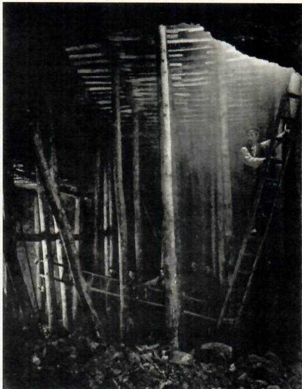
Abb. 54: Im Abbau „unter Tage“: Die Grundfläche einer Kammer betrug ca. 25 m 2 , die Höhe bis 4 m und das Abbauvolumen bis 100 m 3 (Bildarchiv R.-G. WEDDE).
