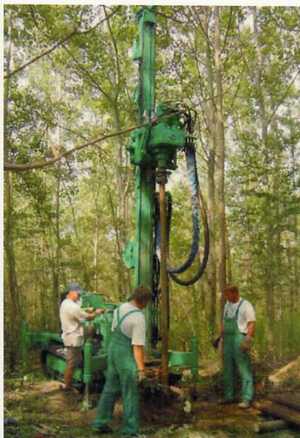
Abb. 57: Einsatz Bohrgerät WD 90 zur Schachtsuche auf dem Galgenberg (Foto: T. GÖBEL)
