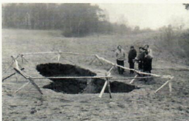
Abb. 7: Tagesbruch „Notkohlengrube Rauen“ bei Petersdorf, Größe: 8 x 3 m; Tiefe: 6 m (Foto: R.-G. WEDDE)
