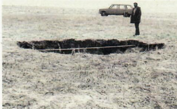
Abb. 8: Tagesbruch Braunkohlengruben „Max“ und „Willenbücher“ Bollersdorf bei Strausberg, Durchmesser: 4,5 m; Tiefe: 2,5 m (Foto: O. SCHERKE)
