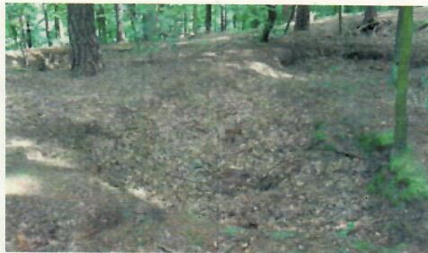
Abb. 56: Tagesbrüche an der Erdoberfläche – derartige Einsenkungen als Folge des Kammer-Pfeiler-Bruchbaus sind auf dem Galgenberg weit verbreitet (Foto: R.-G. WEDDE).
