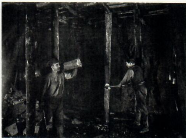
Abb. 55: „Rauben“ des Ausbauholzes: War das Flöz in der Kammer ausgekohlt, wurde das Deckgebirge durch „Rauben“ der Zimmerung zielgerichtet zu Bruch geführt (Bildarchiv R.-G. WEDDE).
